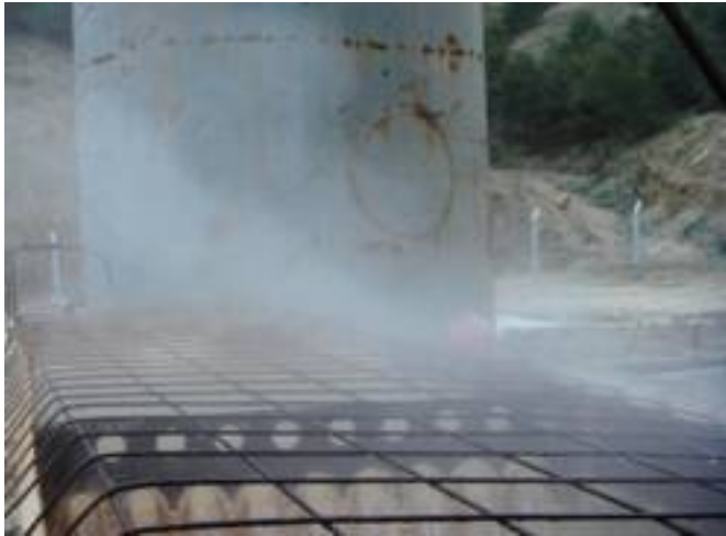
Pozzo geotermico in Turchia. Il fumo che si vede in primo piano e che si libera nell'impianto di decantazione non è vapore, ma CO 2 quasi pura al 98%. Può essere filtrata e immessa in serra.
